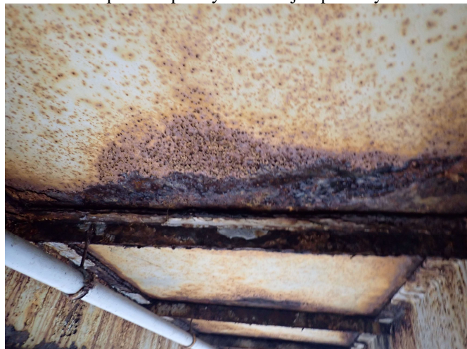
Zkorodované pochozí plechy a korodující příčníky
